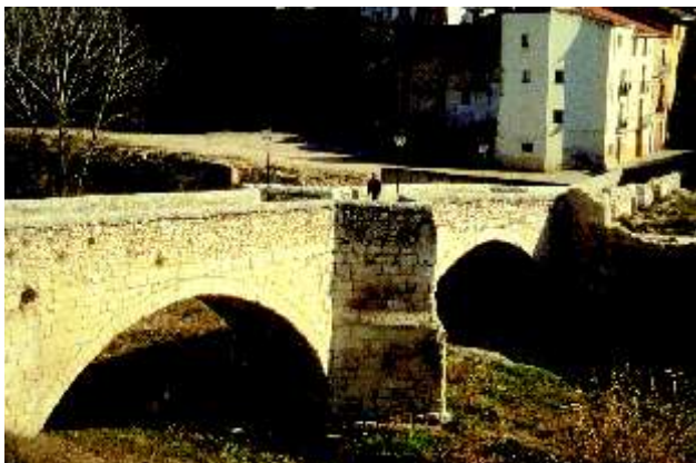
Pont de la Cantereria. Ontinyent
